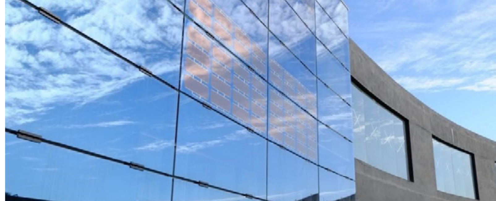
Foto: OPV aplicado no prédio da Inovalli em São Paulo. Projeto foi concluído no final de 2016.
